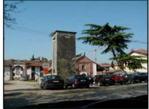
Edificio a torre utilizzato come cabina Enel - Cascina Campagna
