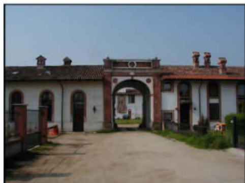
Arco ingresso corte e voltini in mattoni pieni posati di coltello - Cascina Campagna
