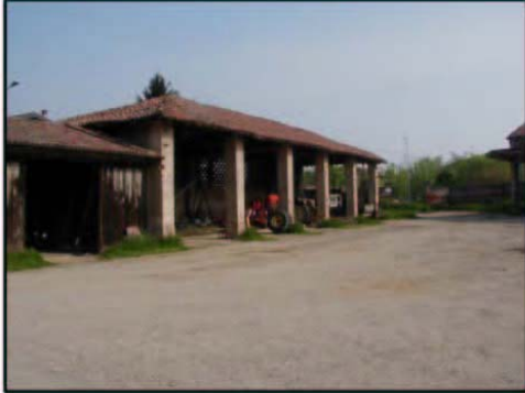
Deposito con pilastri in mattoni a vista e copertura in legno - Cascina Morelli
