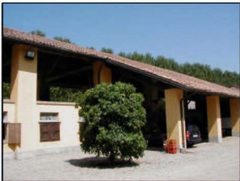
Porticato con pilastri intonacati - Cascina Barchette
