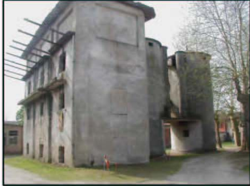
Edificio a torre (silos) per stoccaggio cereali - Cascina .....
