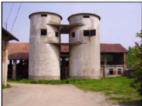
Edificio a torre (silos) per stoccaggio cereali - Cascina Grande
