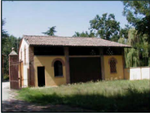
Arco sopra finestra e lesene in mattoni a vista - Cascina Barchette
