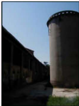
Edificio a torre (silos) per stoccaggio cereali - Cascina Barchette
