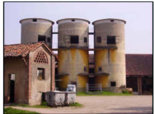
Edificio a torre (silos) per stoccaggio cereali - Cascina Carpana
