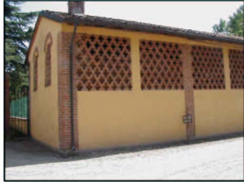
Muratura in mattoni pieni a frangisole - Cascina Barchette
