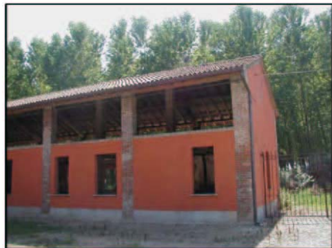
Marcapiano realizzato in mattoni a vista posati di coltello - Cascina Barchette
