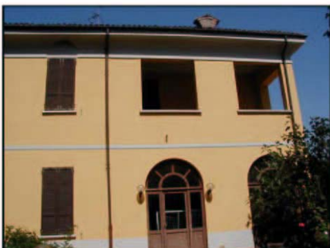
Marcapiano realizzato in cemento - Casa padronale Cascina Barchette
