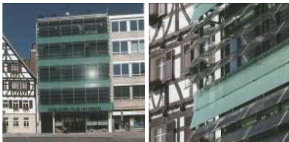
Fig 75. Edificio Zoller-alb-Kurier, Monaco di Baviera. La facciata di rottura rispetto all'edificio tradizionale non presenta soluzioni di continuità rispetto alla facciata moderna limitrofa. La discromia poteva essere evitata scegliendo un colore del vetro più adeguato rispetto al fronte strada. (BIPV)
