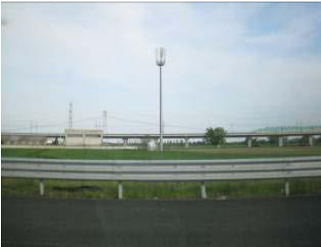
Fig 113. Autostrada Torino – Milano. L'antenna installata in campo aperto è fortemente visibile anche da lunga distanza. Le antenne isolate devono essere programmate, se possibile, in zone in ombra, su sfondi strutturati. Sullo sfondo tralicci di elettrodotti.
