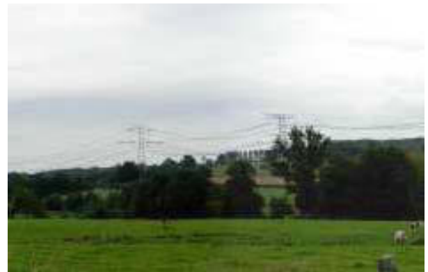
Fig 11. La struttura del paesaggio: un paesaggio con elementi costitutivi di grandi dimensioni permette una visione a lunga distanza. Gli eventuali elettrodotti presenti saranno perciò altamente visibili se collocati in campo aperto. È quanto mai opportuno che essi siano collocati in prossimità degli elementi che costituiscono i margini del paesaggio.
