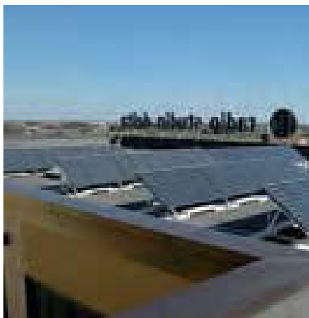
Fig 65. Nel caso di installazione su tetto piano occorre prevedere che l'altezza dei moduli fotovoltaici misurata da terra fino all'asse mediano degli sessi non superi l'altezza dell'eventuale cornicione o balaustra. (GSE, "Guida agli interventi validi ai fini del riconoscimento dell'integrazione architettonica del fotovoltaico").
