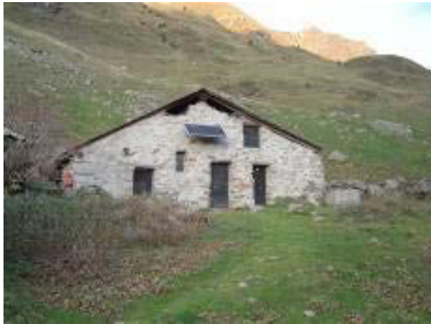
Fig 60. Alpeggio in alta Val Seriana: l'installazione del pannello fotovoltaico è avvenuta in posizione inadeguata rispetto all'edificio. Nel caso di integrazione all'interno di edifici con caratteri costruttivi tradizionali, le installazioni dovrebbero essere posizionate sulle falde di copertura non visibili dalle visuali principali o a terra, debitamente mitigati rispetto ai percorsi di fruizione e accessibilità pubblica.
