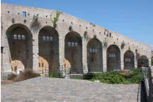
Fig 59. Castello Doria a Porto Venere ( www.pvaccept.de/ita/portovenere.htm ): negli archi della muraglia, sono state installate delle "solar flags" costituite da elementi trasparenti nei quali sono inserite cellule solari grigie.
