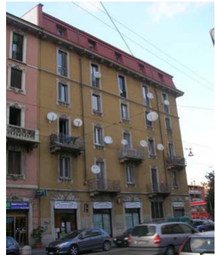
Fig 95. Antenne paraboliche televisive
