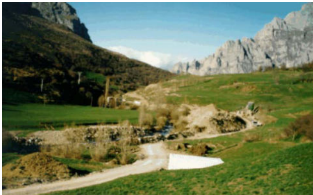
Fig. 35. L'impianto di Cordinanes nel Picos de Europa (Spagna) (ESHA, Guida all'idroelettrico minore, 1998): il canale a pelo libero in calcestruzzo che parte dall'opera di presa è stato interamente interrato e ricoperto con uno strato di terreno rivegetato. Le fotografie mostrano un tratto di canale nelle tre fasi di costruzione: scavo, getto del calcestruzzo e canale finito con lo strato di terreno rinverdito.
