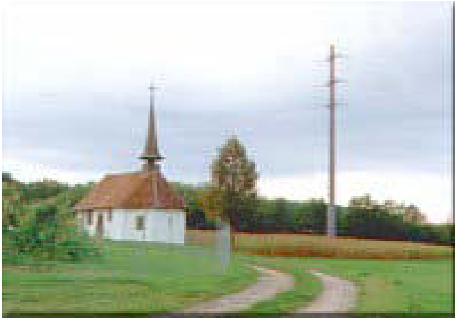
Fig 30. Criteri di posizionamento ( www.bafu.admin.ch ): il posizionamento dei piloni di sostegno delle linee aeree in prossimità di una piccola chiesa con campanile ha, in questo caso, impatto negativo sul paesaggio in quanto il punto focale visivo diventa non più il campanile ma l'adiacente pilone che lo supera in altezza.
