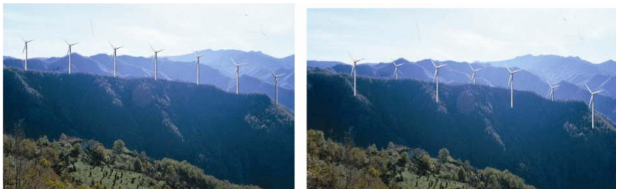
Fig 44. Criteri di posizionamento ( Regione Toscana, Linee guida per la valutazione dell'impatto ambientale degli impianti eolici, 2004 ): le due simulazioni mostrano il differente effetto visivo della disposizione lineare lungo la linea del crinale e a cavallo dello stesso. In quest'ultimo caso le macchine sono parzialmente nascoste dal fianco del crinale.
