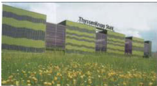
Fig 79. Stabilimento industriale, Germania. Gli impianti fotovoltaici creano occasione di conferire un aspetto innovativo ai prospetti di un grande capannone industriale. La scelta del colore e della modalità di installazione permettono una migliore integrazione nel contesto rurale dell'industria. (THERMIE)
