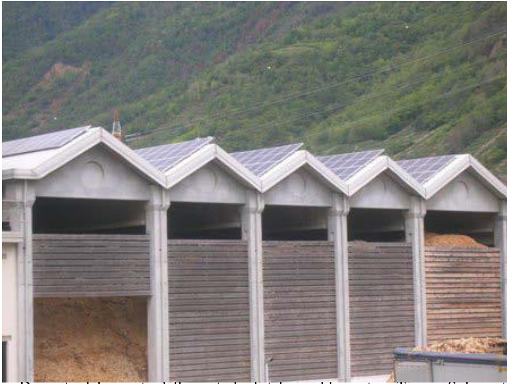
Fig 87. Deposito del cippato della centrale di teleriscaldamento a Tirano. Sul suo tetto è stato realizzato un impianto fotovoltaico.
