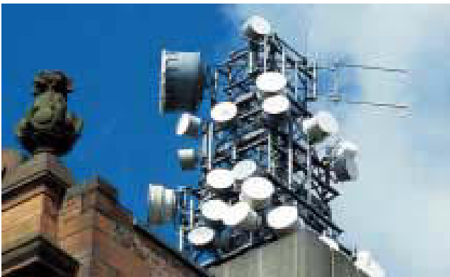
Fig 111. La condivisione delle torri è la soluzione più veloce ed economica in alcune situazioni aggiungendo nuove antenne su torri esistenti. Tuttavia in altre circostanze la condivisione delle torri può risultare di grande impatto visivo rispetto a molte torri piccole diffuse. Nel caso venga scelta la condivisione bisogna porre attenzione all'interferenza delle frequenze radio e alla portanza della torre. Infatti qualora compaiano interferenze è necessario aumentare la potenza emissiva dell'antenna aumentando conseguentemente il suo impatto visivo. Qualora venga scelto di installare diverse antenne in un unico luogo, è necessario rendere ordinata l'installazione progettando a blocco unico tutti i dispositivi accessori.
