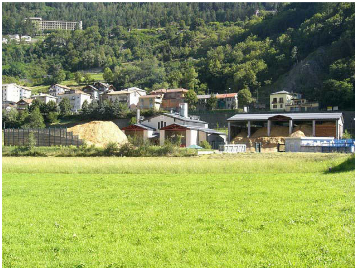
Fig 83. Forme, materiali, colori (Lombardia verde, Aprile 2007): centrale di teleriscaldamento a Sondalo alimentata a biomassa; la dimensione contenuta degli edifici e l'uso dei tetti a falda tipici dell'abitato consentono un inserimento non dissonante rispetto al contesto.
