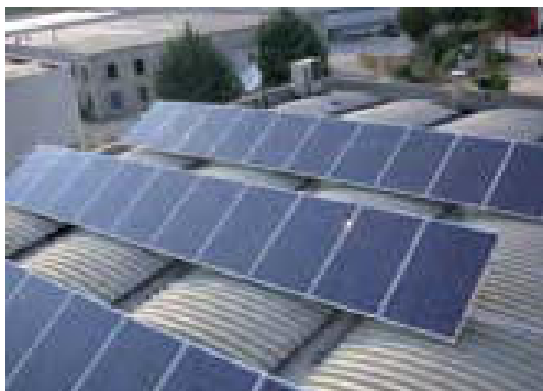
Fig 65. Nel caso di installazione su tetto piano occorre prevedere che l'altezza dei moduli fotovoltaici misurata da terra fino all'asse mediano degli sessi non superi l'altezza dell'eventuale cornicione o balaustra. (GSE, "Guida agli interventi validi ai fini del riconoscimento dell'integrazione architettonica del fotovoltaico").
