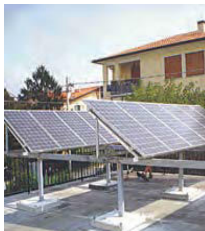
Fig 65. Nel caso di installazione su tetto piano occorre prevedere che l'altezza dei moduli fotovoltaici misurata da terra fino all'asse mediano degli sessi non superi l'altezza dell'eventuale cornicione o balaustra. (GSE, "Guida agli interventi validi ai fini del riconoscimento dell'integrazione architettonica del fotovoltaico").
