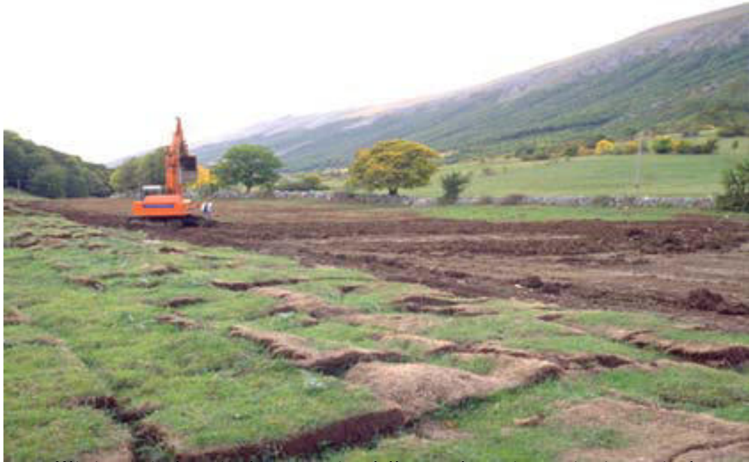
Fig 93. Gli impatti dovuti al passaggio delle condotte in territorio agricolo sono, generalmente temporanei e tuttavia non trascurabili in quanto comportano innanzitutto la perdita delle colture esistenti che dovranno opportunamente essere ripristinate. In particolare i terreni agricoli attraversati e interessati da colture a ciclo annuale dovranno il prima possibile essere posti nella condizione per la ripresa delle originarie capacità produttive ( www.snamretgas.it ).
