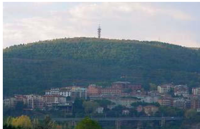
Fig 102. Torre e Ponte Radio a Chianciano Terme ( www.costruzionifabrizi.it ): la predominanza del ponte radio introduce un nuovo punto focale all'interno del paesaggio di cui diventa simbolo. L'introduzione di un nuovo elemento deve essere quindi studiata in modo da non sconvolgere totalmente il sistema complesso delle relazioni del paesaggio storico.
