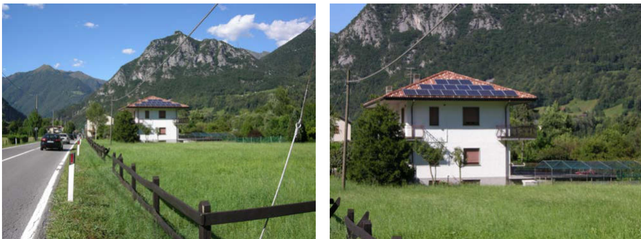
Fig 62. L'inserimento di pannelli fotovoltaici su un'abitazione in un paesaggio di montagna. I pannelli sono posizionati sulla falda più visibile dalla strada per problemi di esposizione. In questo caso è da valutare la possibilità di installare i pannelli a terra. Nel caso di installazione su falda essa dovrà essere particolarmente curata, adottando colori simili a quelli della copertura.
