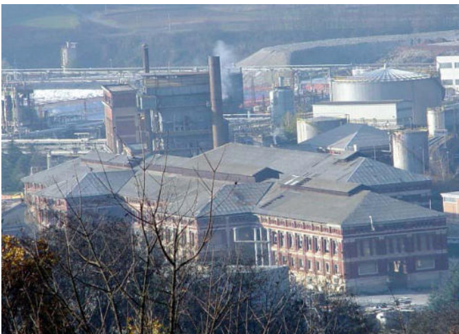
Fig 107. I paesaggi industriali sono generalmente caratterizzati dalla presenza di edifici di grossa taglia e disposti su grandi superfici; essi rappresentano, perciò, spesso un contesto in cui gli impianti possono trovare adeguata integrazione rappresentando un elemento tecnologico congruente con le destinazioni d'uso già in essere.
