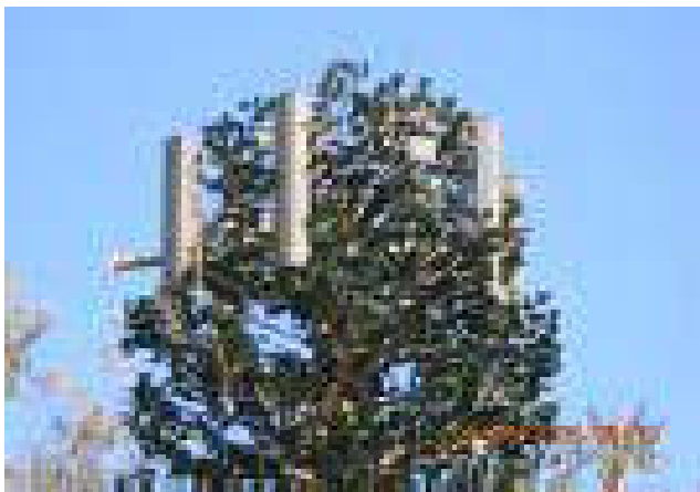
Fig 109. Criteri di posizionamento (Planning Advice Note: PAN 62 Radio Telecommunications, Scottish executive, 2001); le linee guida della Scozia fanno notare come, qualora si scelga di installare le antenne su alberature esistenti, sia opportuno disporle in maniera tale che non siano visibili tenendo conto delle variazioni della chioma durante il corso dell'anno.
