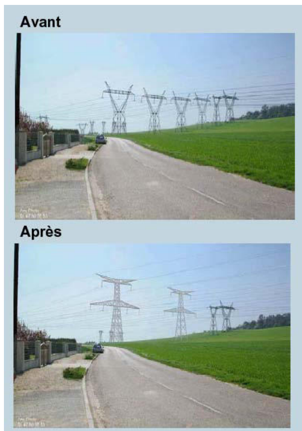
Fig 24. Razionalizzazione delle linee elettriche in prossimità di una centrale di trasmissione (RTE, Poste électrique du Chesnoy, Dossier de presse 2008) : le linee sono state raggruppate al fine di ridurre il numero dei piloni. Ciò comporta, tuttavia, una maggiore altezza dei sostegni.
