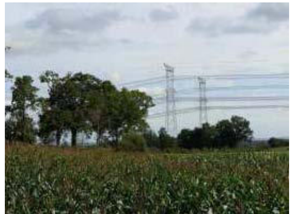
Fig 16. La scelta del tracciato: laddove risulti possibile è opportuno gemellare le linee elettriche per evitare tracciati paralleli inutili che sovraccaricano la vista.
