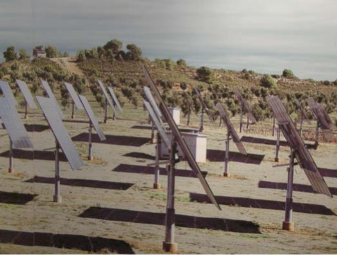
Fig 55. La scelta dell'ubicazione: le aree agricole risultano sempre di grande criticità per l'installazione di parchi fotovoltaici. Nel caso in cui ciò non sia evitabile è necessario studiare attentamente il posizionamento dei collettori in relazione alla tessitura territoriale e usare sostegni il meno possibile invasivi non soltanto nel soprasuolo ma anche nel sottosuolo. Essi costituiscono una sottrazione di territorio all'uso agricolo e una intrusione nel paesaggio agrario.
