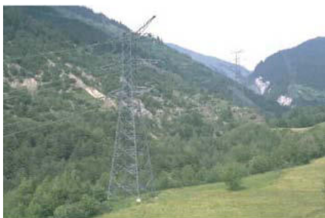
Fig 7. Esempio di assorbimento di un pilone nel paesaggio ( www.cotentin-maine.com ): la scelta dell'ubicazione del pilone e il suo colore permettono di mimetizzare in parte la linea.
