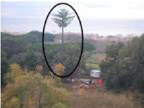
Fig.115. La mimetizzazione delle antenne attraverso il camuffamento deve evitare il fuori scala e utilizzare specie botaniche che imitino quelle già presenti nel luogo di installazione.
