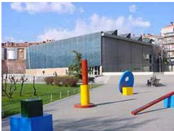
Fig 77. Biblioteca pubblica a Matarò, Spagna. L'edificio si pone in una piazza aperta. La scelta del colore e della tipologia di facciata continua sono di grande impatto rispetto alle quinte urbane di fondo. Soprattutto per edifici collocati in spazi aperti occorre porre particolare attenzione alla scelta del colore e della tessitura poiché la grande visibilità aumenta l'impatto dell'installazione. (BIPV)
