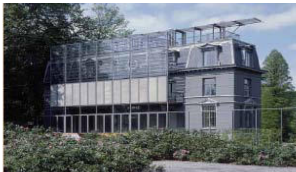
Fig 76. Castello di Groenhof, Belgio. La scelta del colore dei moduli inseriti all'interno della nuova struttura, si integra in maniera consona con il colore dell'edificio storico. (BIPV)
