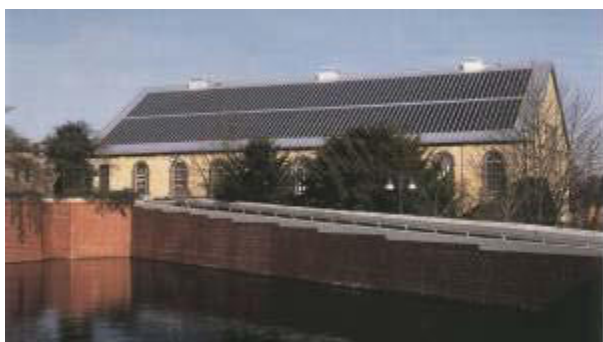
Fig 78. Installazione in copertura a falde, Germania. La disposizione lineare dei moduli, le dimensioni e la scansione ritmica, secondo le nervature della copertura esistente, permettono una buona integrazione dell'impianto. (BIPV)
